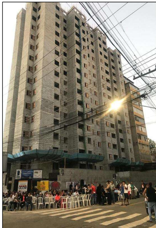
Figura 7: Programa Pode Entrar – Obras do edifício Carlos Mariguella, maio/2024.
