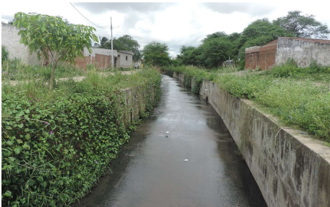
Figura 6. Curso d'água canalizado, cercado por vias de acesso não pavimentadas e com vegetação.
