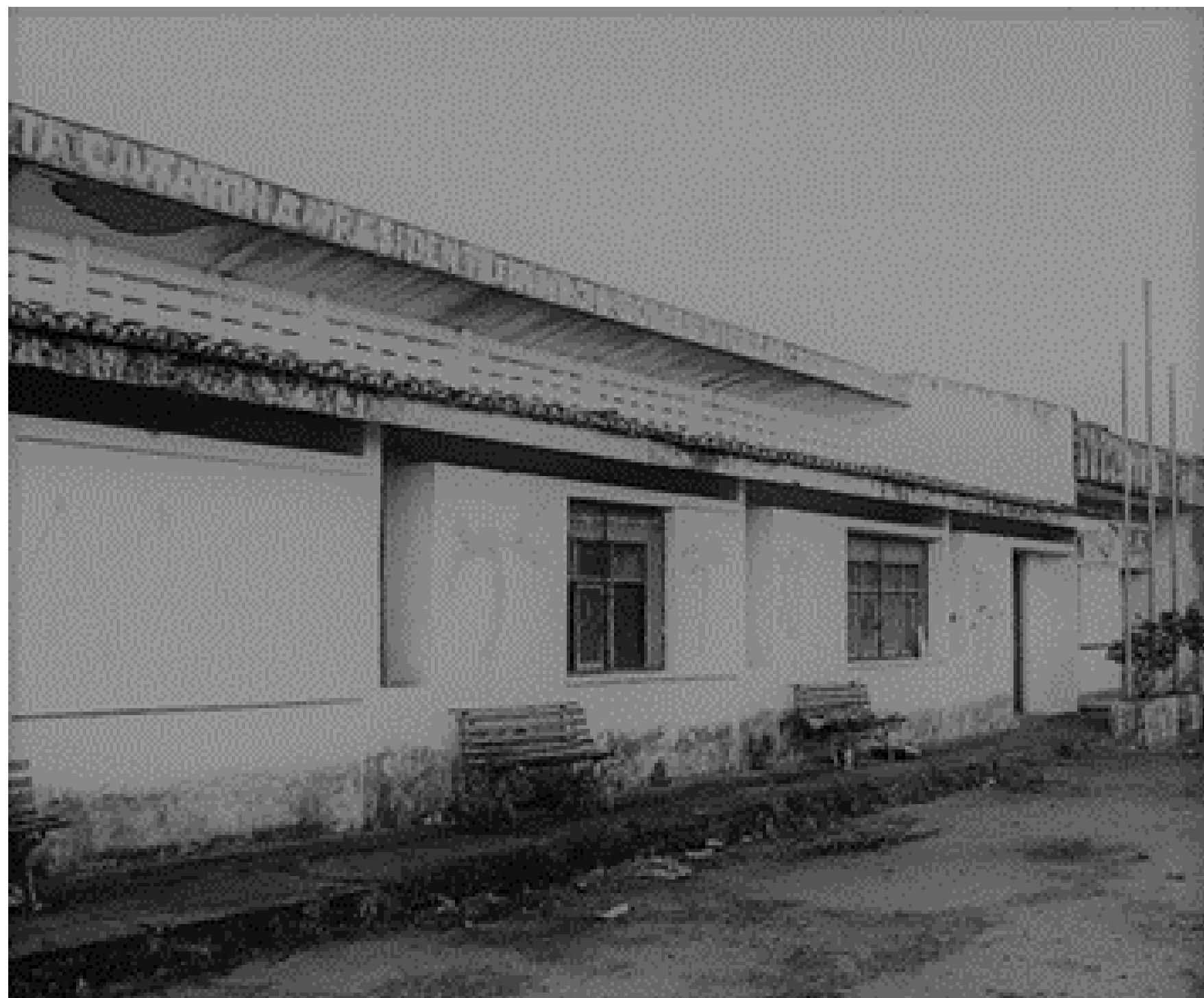
Centro Comercial Comunitário, composto por 20 boxes, oferece a venda de gêneros alimentícios de primeira necessidade e diversos serviços. Observa-se que em todos os conjuntos recém inaugurados havia sempre a construção de uma igreja católica empreendida pelo pároco Tiago Theisen. Fonte: Anderson, 2019.
