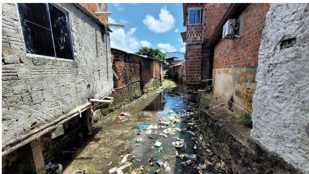
Evidência da precariedade e de descarte inadequado de esgoto na comunidade Bomba do Hemetério, no Recife. / Crédito: Arnaldo Souza
