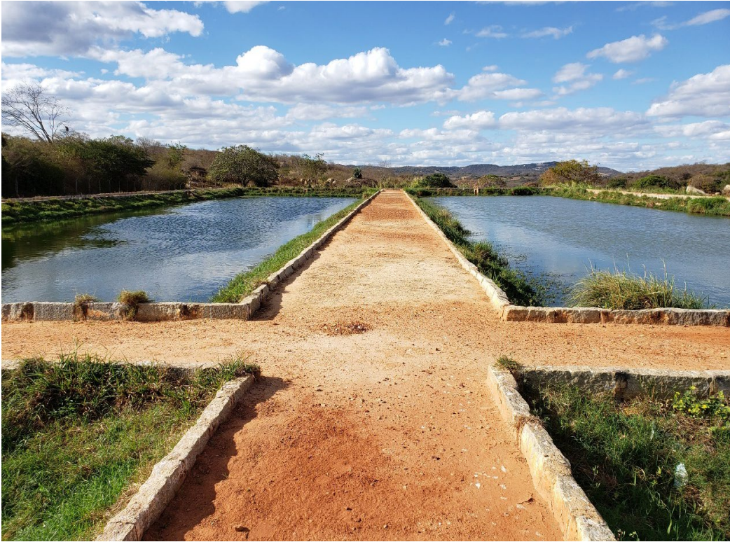
Estação de Tratamento de Esgoto de Matureia.
