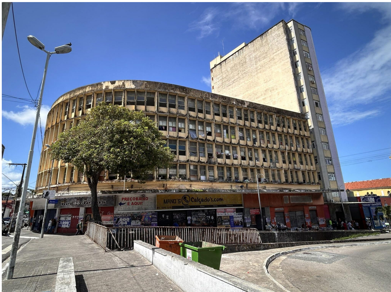
Ocupação João Pedro Teixeira - Edifício Nações Unidas, localizado no centro antigo da cidade de João Pessoa (PB).
