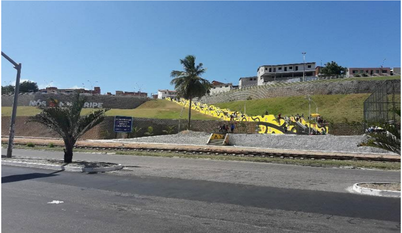
Figura 2 - Intervenção em comunidade do bairro Vicente Pinzon
