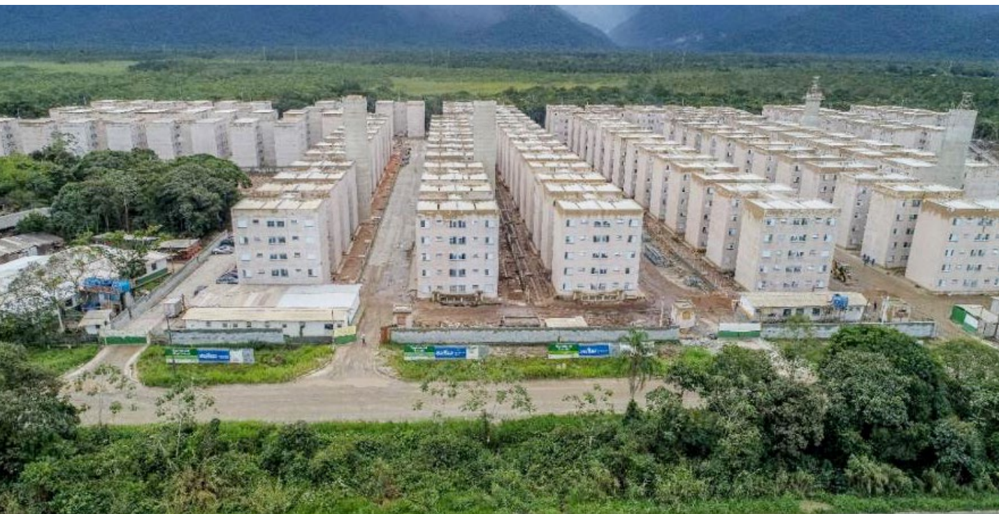
Imagem do conjunto habitacional em Bertioga, na Baixada Santista, durante sua construção.
