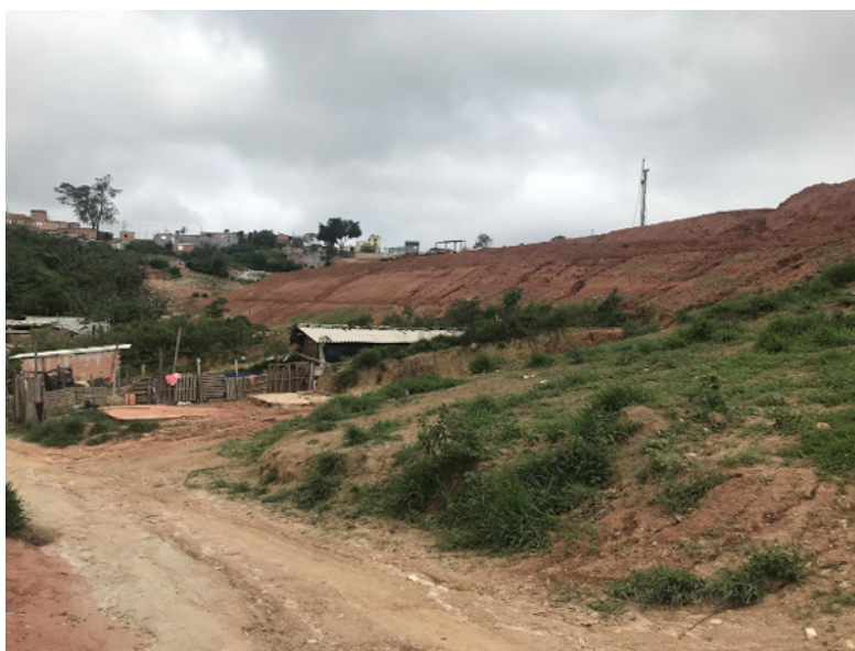
Figuras 10.3, 10.4 e 10.5 – Moradias na linha de drenagem e de escorregamentos
