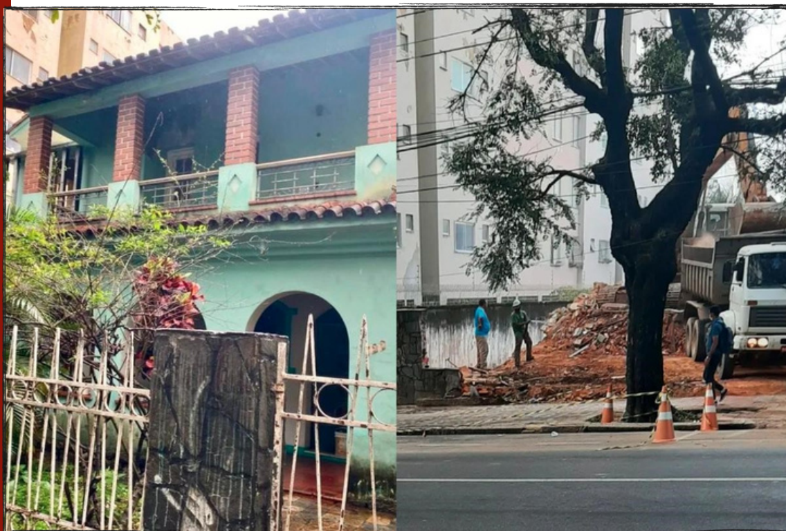
Figura 3 - Imóvel ocupado em Belo Horizonte e em seguida demolido
