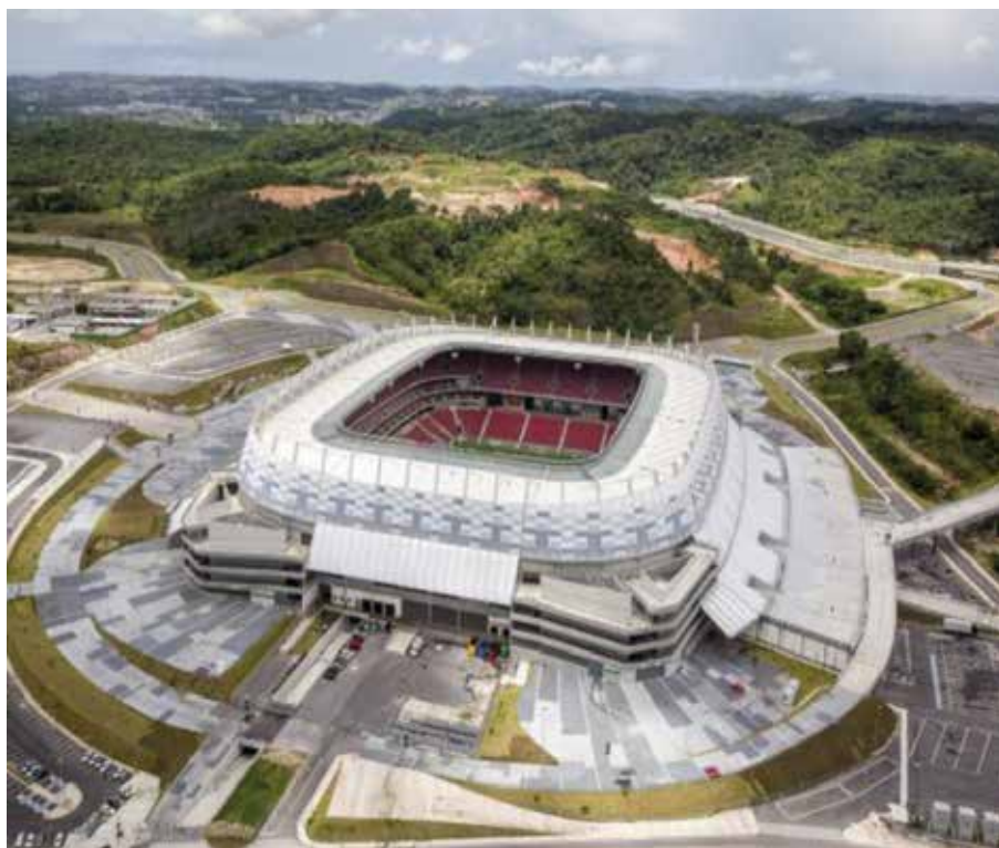
Figura 12. Arena e área da Cidade da Copa/ São Lourenço da Mata (sentido Oeste)
