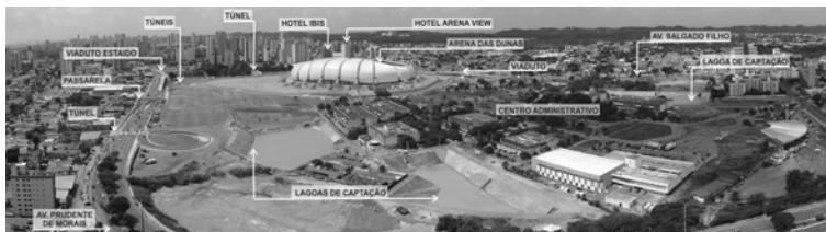
Figura 6 – Identificação de obras do entorno do Arena das Dunas
