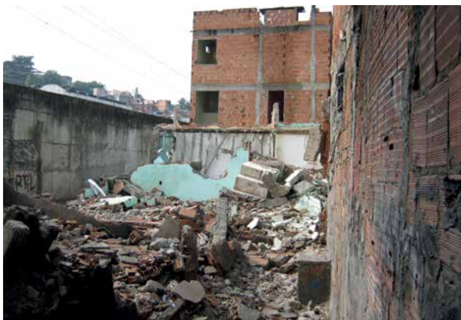
Imagem 27 - Comunidade do Metrô da Mangueira Riscos dos escombros produzidos pela Prefeitura. Foto: Orlando Alves dos Santos Junior, 2011
