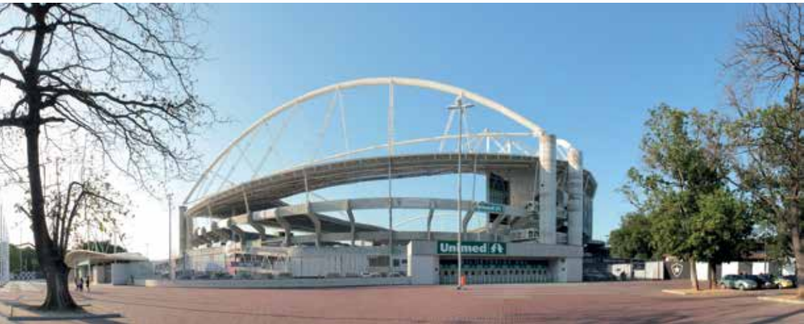
Imagem 21: Estádio Olímpico João Havelange (Engenhão), construído na Zona Norte da Cidade do Rio de Janeiro. Foto: Julio Ferretti, 2011
