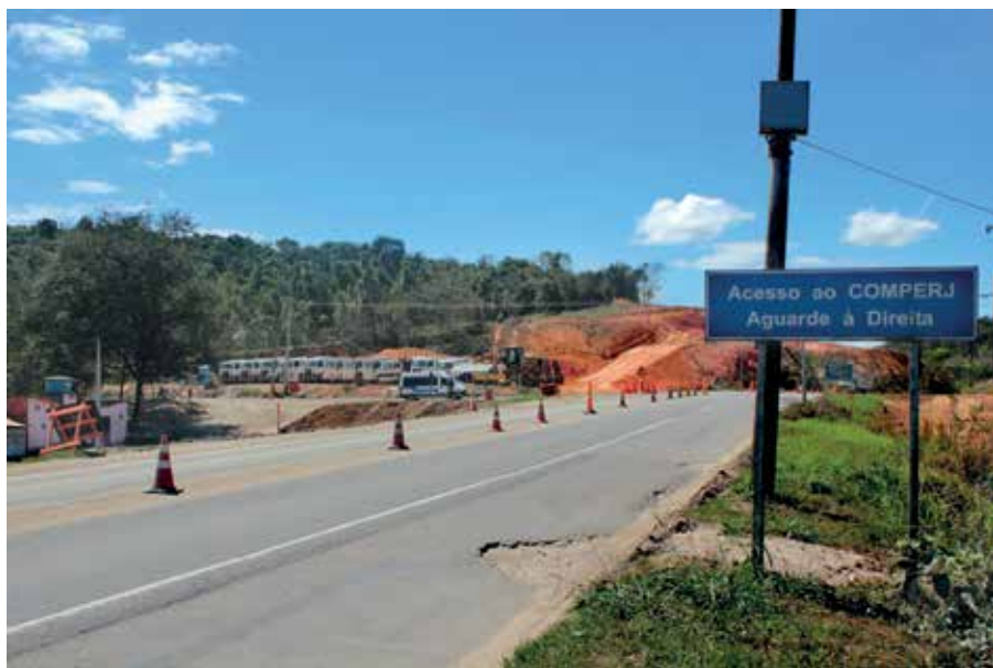
Imagens 13, 14 e 15: Acesso às obras do Complexo Petroquímico do Estado do Rio de Janeiro (COMPERJ): detalhes. Fotos: Julio Ferretti, 2011
