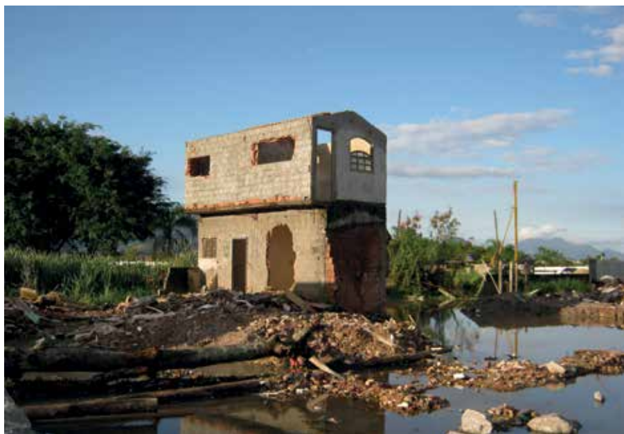
Imagem 26 - Comunidade da Vila Recreio II Demolições das casas para a construção da Transoeste. Foto: Orlando Alves dos Santos Junior, 2011
