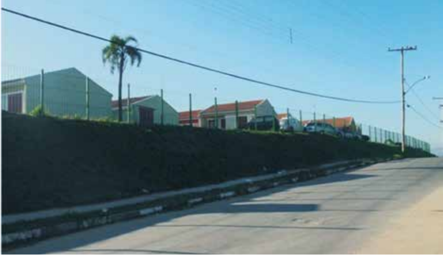
Condomínio ao lado do empreendimento Vivendas São Tomé, em Viamão, Rio Grande do Sul. Foto: Julia Wartchow
